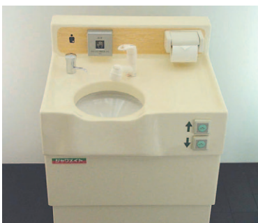
昨年12月に設置された、オストメイト専用トイレ
